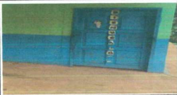
Foto 2: Cambio de puerta por una de metal con chapa
