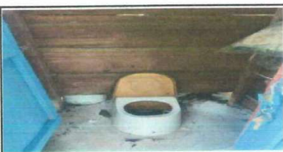
Foto 5: Sustitución de dos sanitarios escolares con paredes de block y cubierta de lamina.
