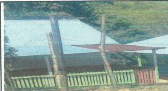
Foto 4: Rehabilitación de paredes de la cocina escolar
