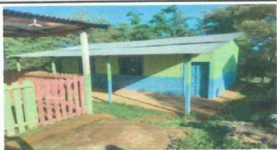
Foto 1: Cambio de entechado por costaneras y columnas.
