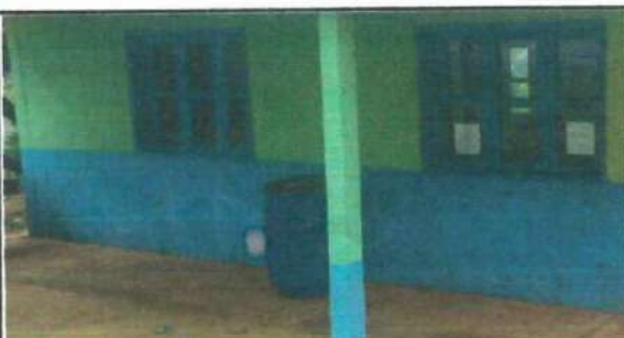
Foto 3: Cambio de las cuatro ventanas
